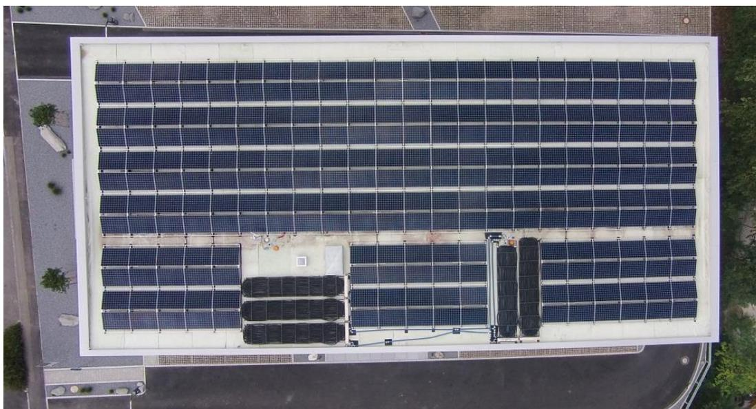
Dachaufsicht mit PV-Anlage und Luftabsorber
